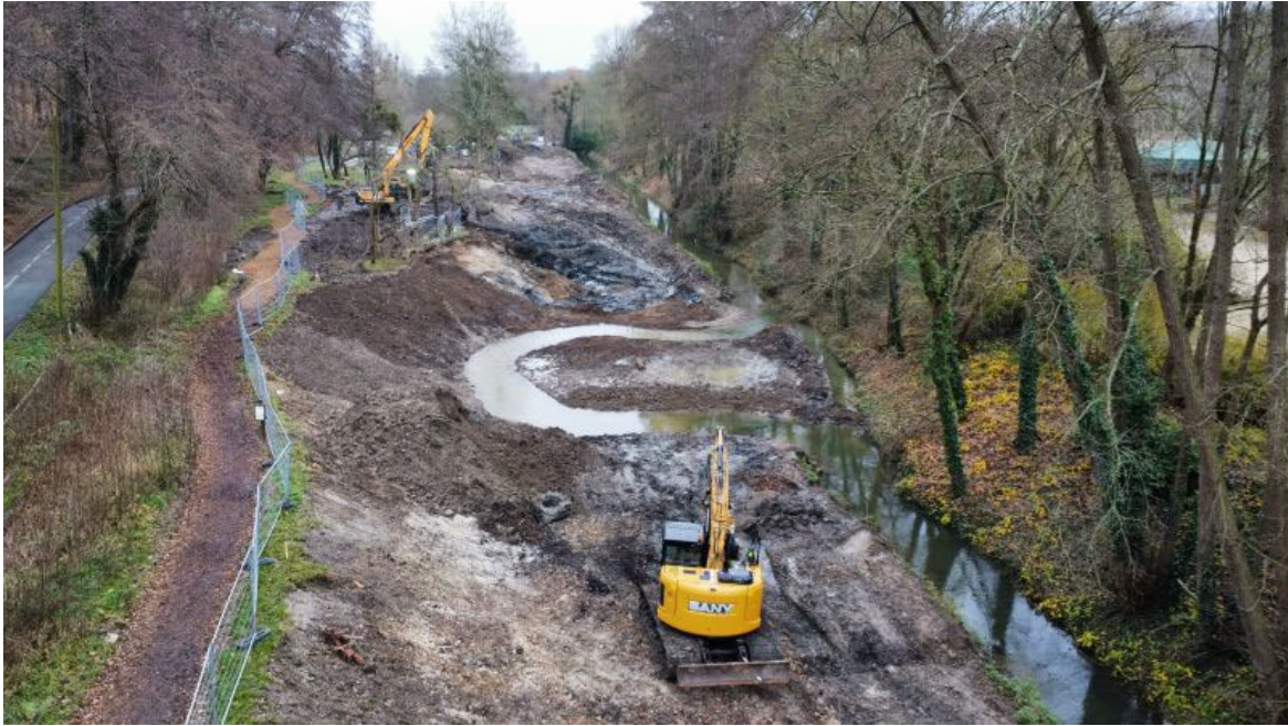
Travaux en cours, décembre 2025, @SIAVB
