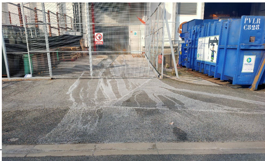
Pollution du ru de Rungis à Rungis sur le site ICADE en avril 2025
