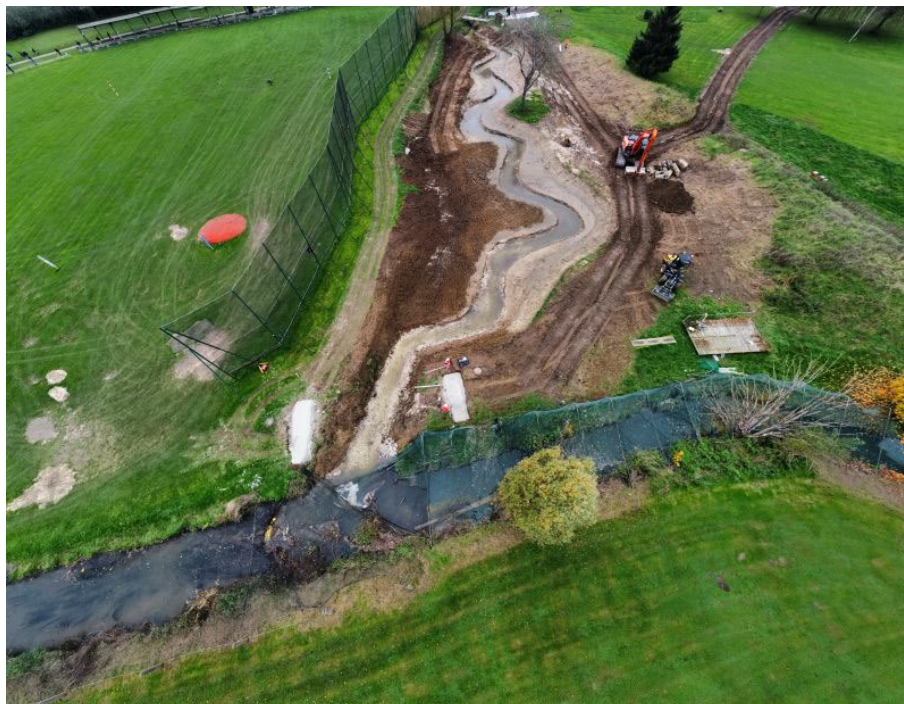
Mise en eau, novembre 2024
