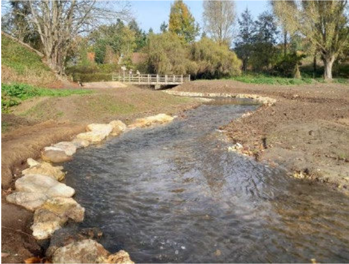
Travaux en cours, novembre 2025, @SIABV
