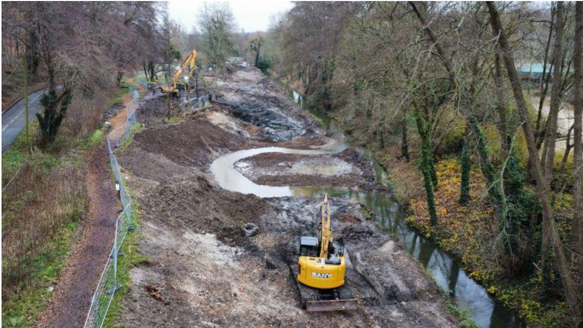
Travaux en cours, décembre 2025, @SIAVB
