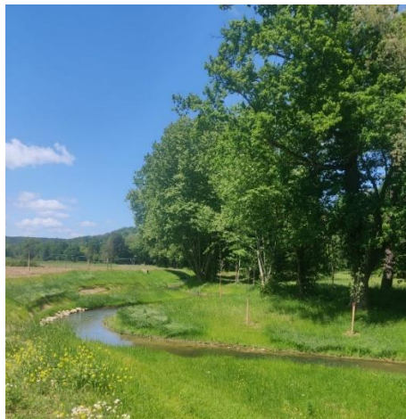
Travaux finalisés, mai 2025, @SMBVB
