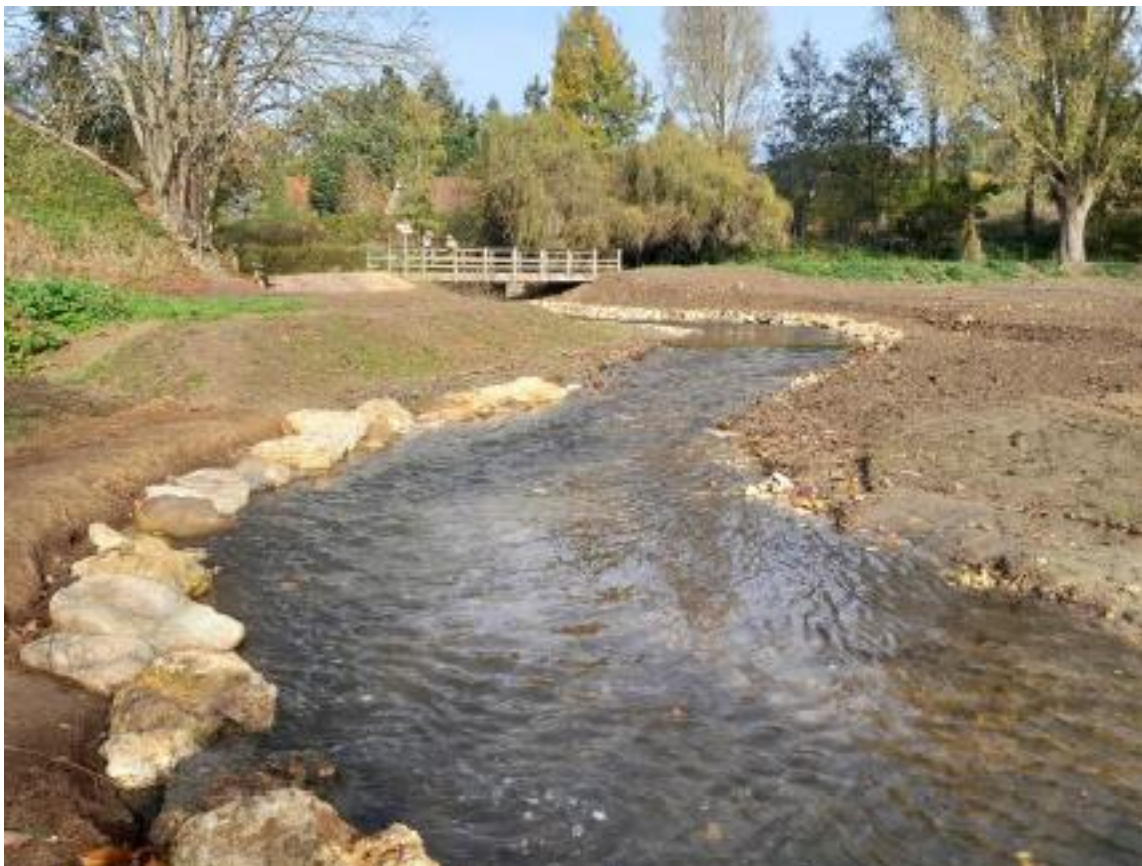
Travaux en cours, novembre 2025, @SIAVB
