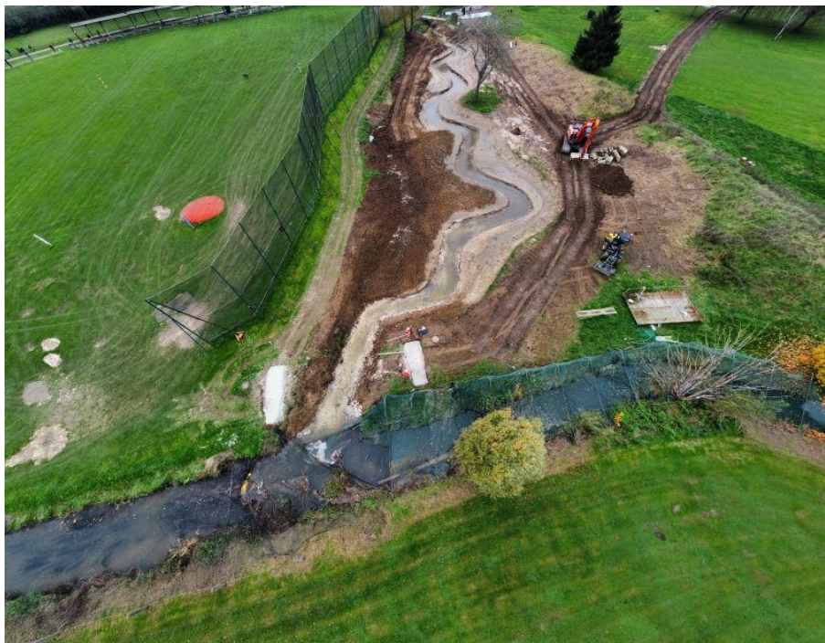
Mise en eau, novembre 2024
